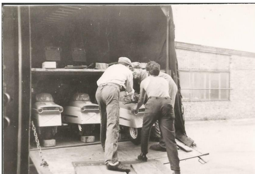
Figuur 6 Vooral de laatste rij was zwaar werk. Hierbij moest er vanaf de achterklep worden gewerkt en met een lange plank. Hierbij kreeg Wim Spaan hulp van twee Heinkel-medewerkers.
